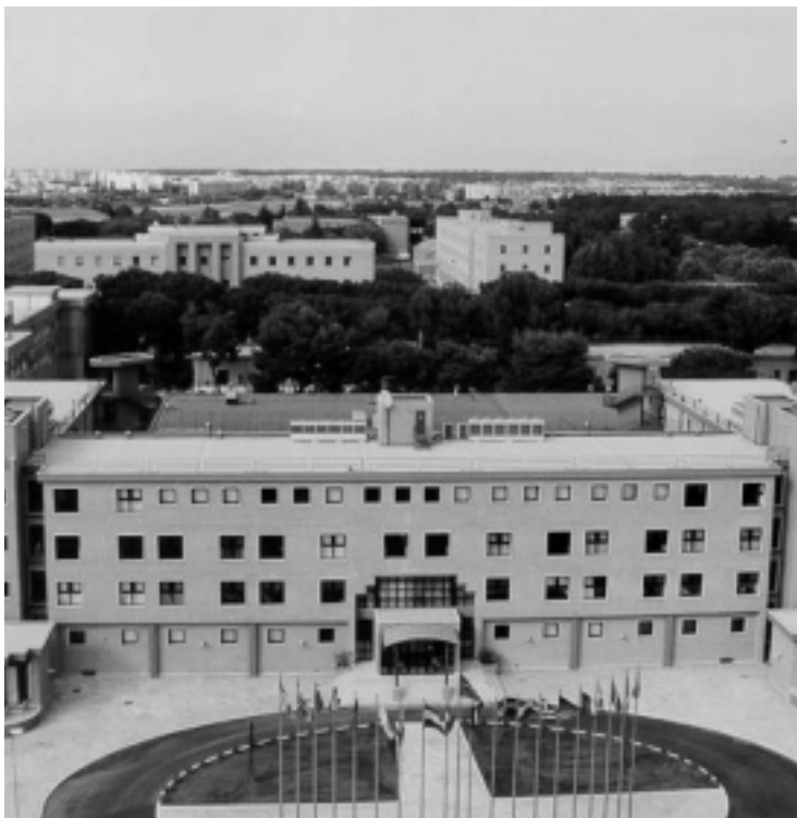
Des installations sur mesure: le Collège de défense de l'OTAN a emménagé dans de nouveaux locaux à l'automne de 1999
