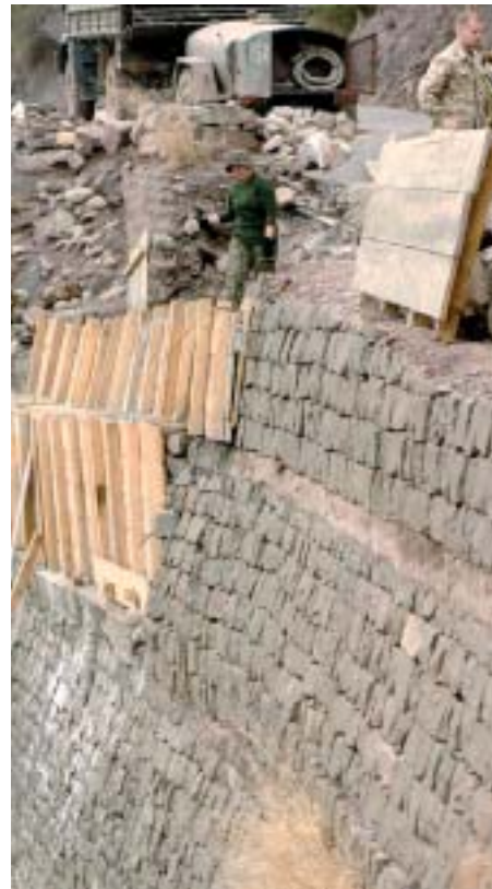
Польські інженери ремонтують дорогу, яку було пошкоджено внаслідок землетрусу у районі Азад Джамму Кашмір, Пакистан.
