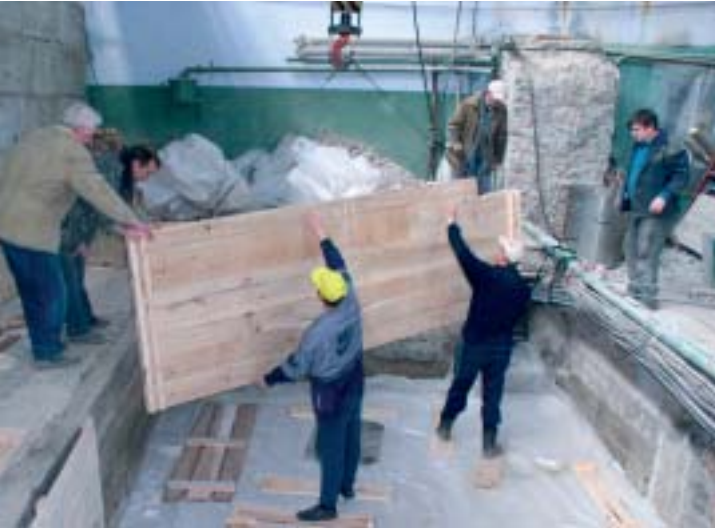
Оборудуется подвальный этаж для размещения циклотрона – генератора рентгеновского излучения
