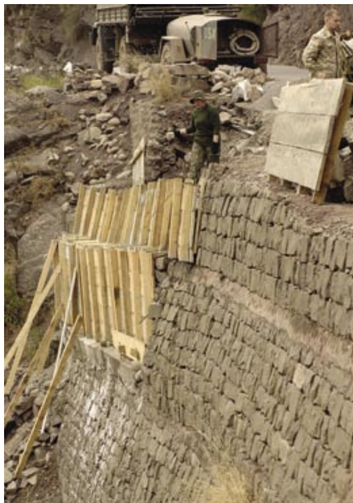
Польское инженерное подразделение ремонтирует дорогу в пострадавшем от землетрясения районе Азад Джамму и Кашмира в Пакистане.
